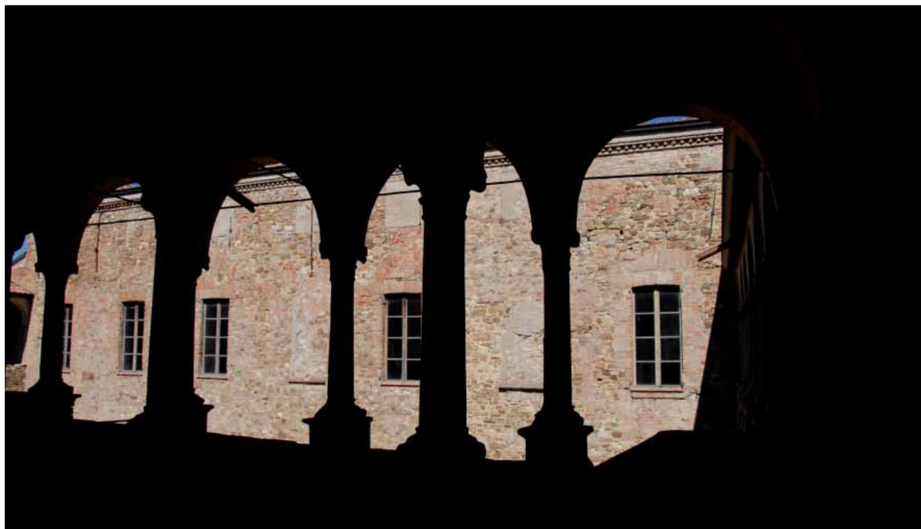
Le colonnine del loggiato della rocca e un fronte interno della rocca dopo i lavori
