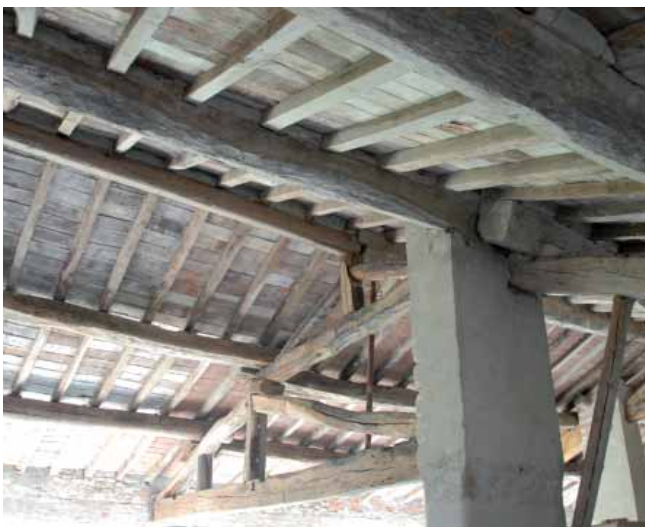
Particolare del tetto della villa dopo i lavori
