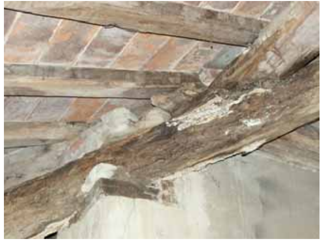
Particolare del tetto della rocca prima dei lavori
