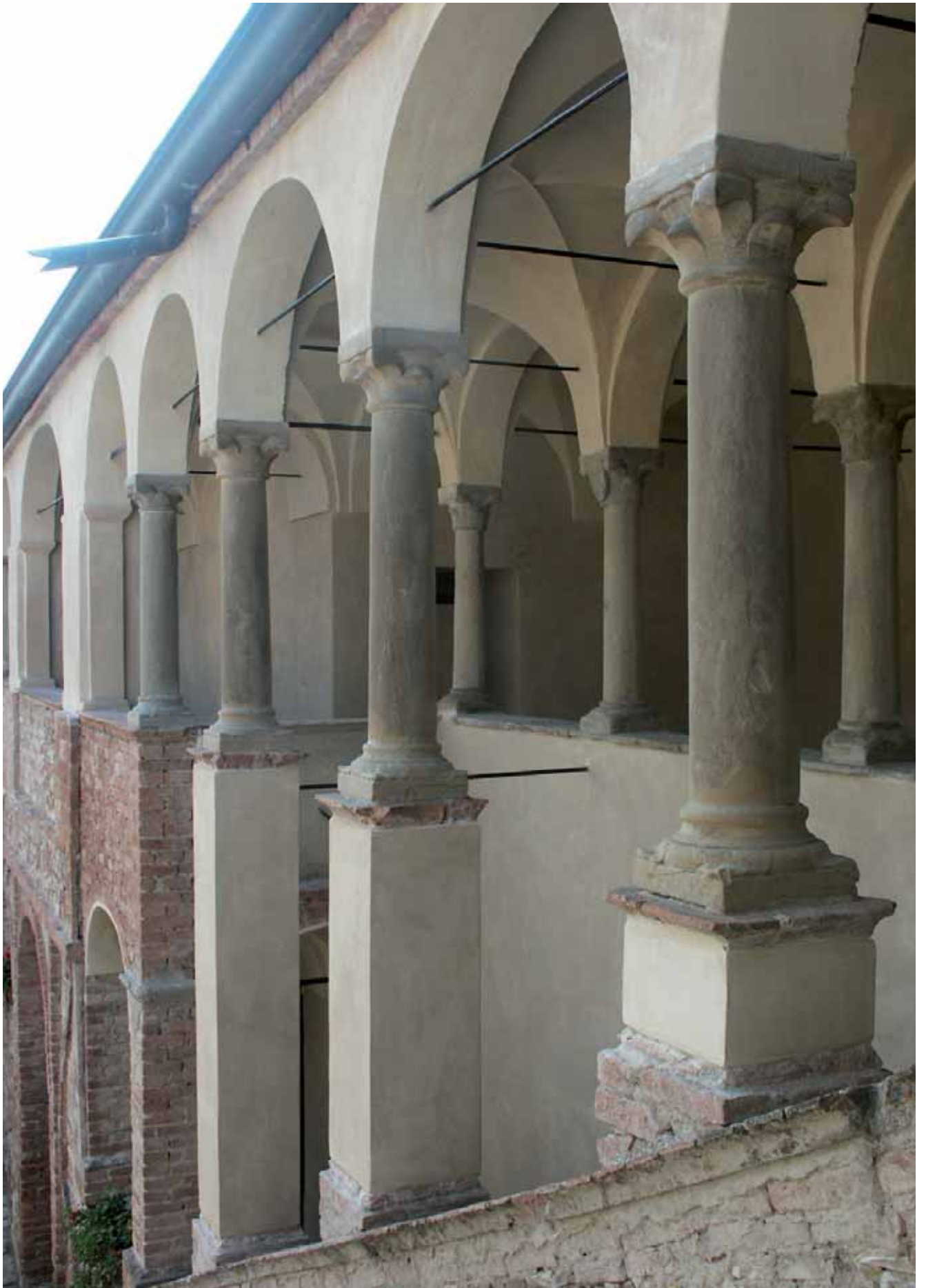
Un particolare del loggiato della rocca dopo i lavori
