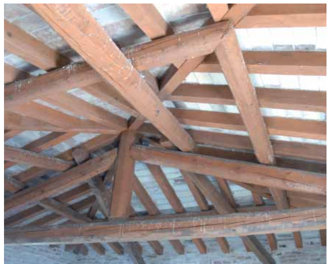
Particolare del tetto della rocca dopo i lavori
