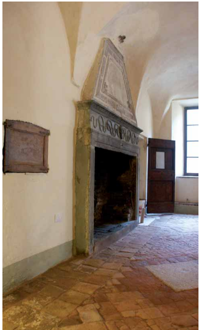
Un vano del piano terra della rocca dopo i lavori
