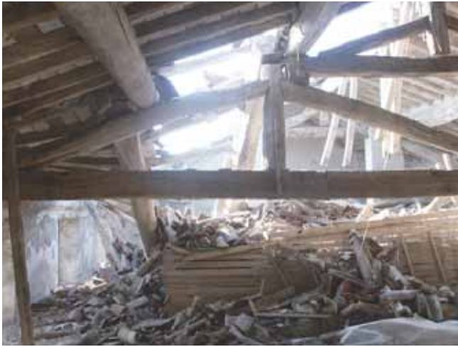
Particolare del tetto della villa prima dei lavori
