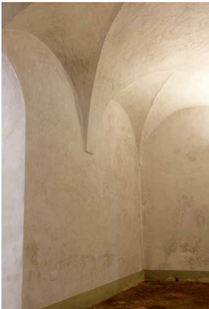
Un particolare di una volta del piano terra della rocca dopo i lavori
