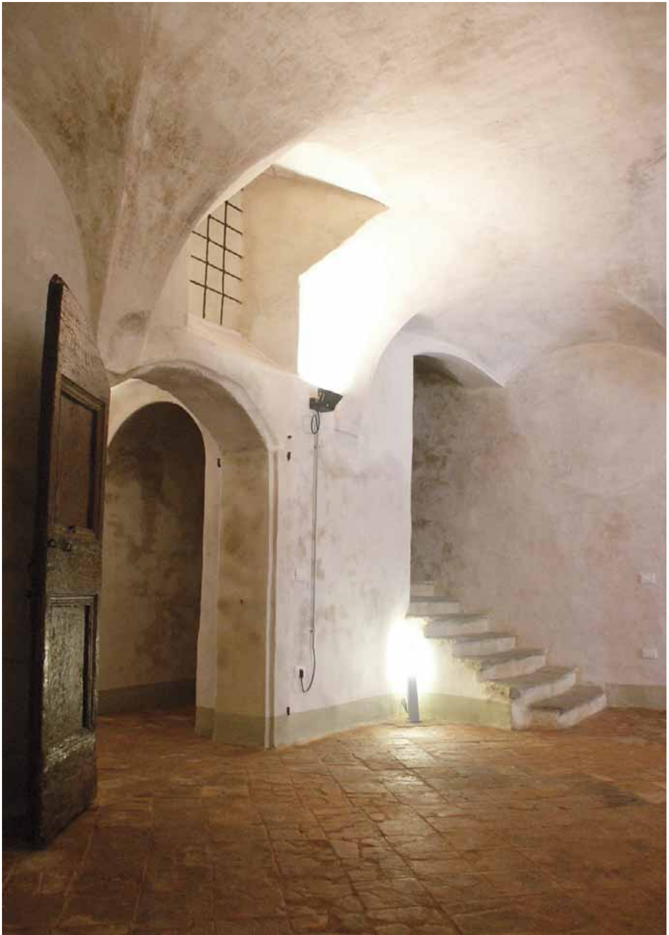
Un particolare dell'ingresso interno del piano terra della rocca dopo i lavori
