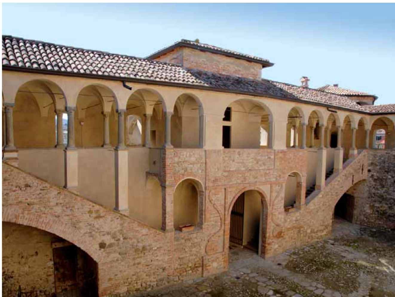
Il loggiato affacciato sul cortile della rocca dopo i lavori
