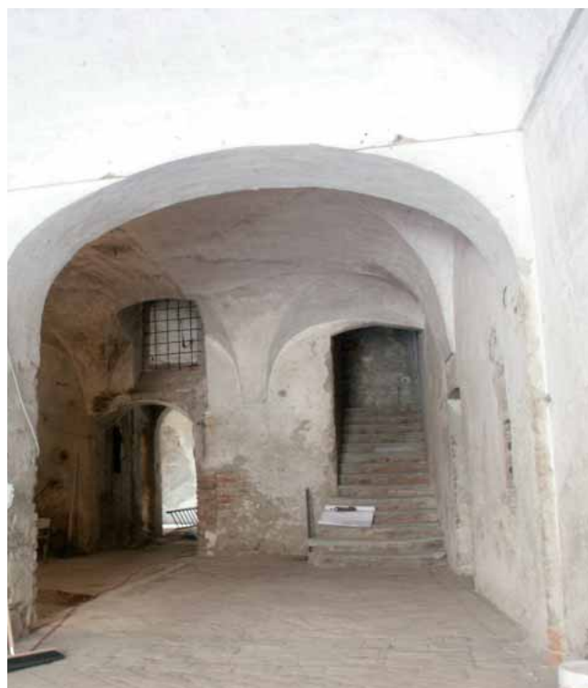
L'ingresso interno del piano terra della rocca prima dei lavori
