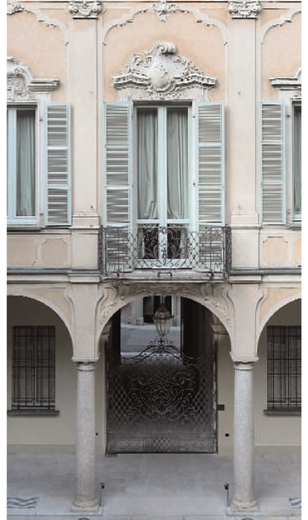
30. Fronte sul cortile d'onore di Palazzo Rota Pisaroni, particolare
