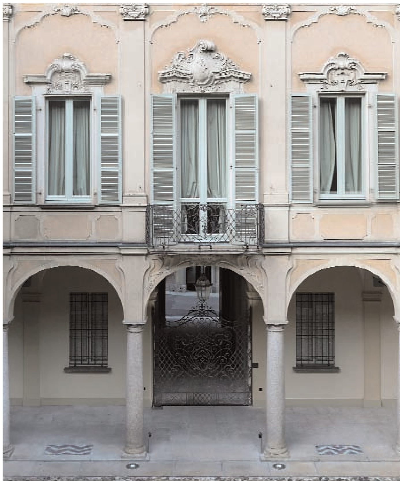
25. Particolare del fronte sul cortile d'onore di Palazzo Rota Pisaroni
